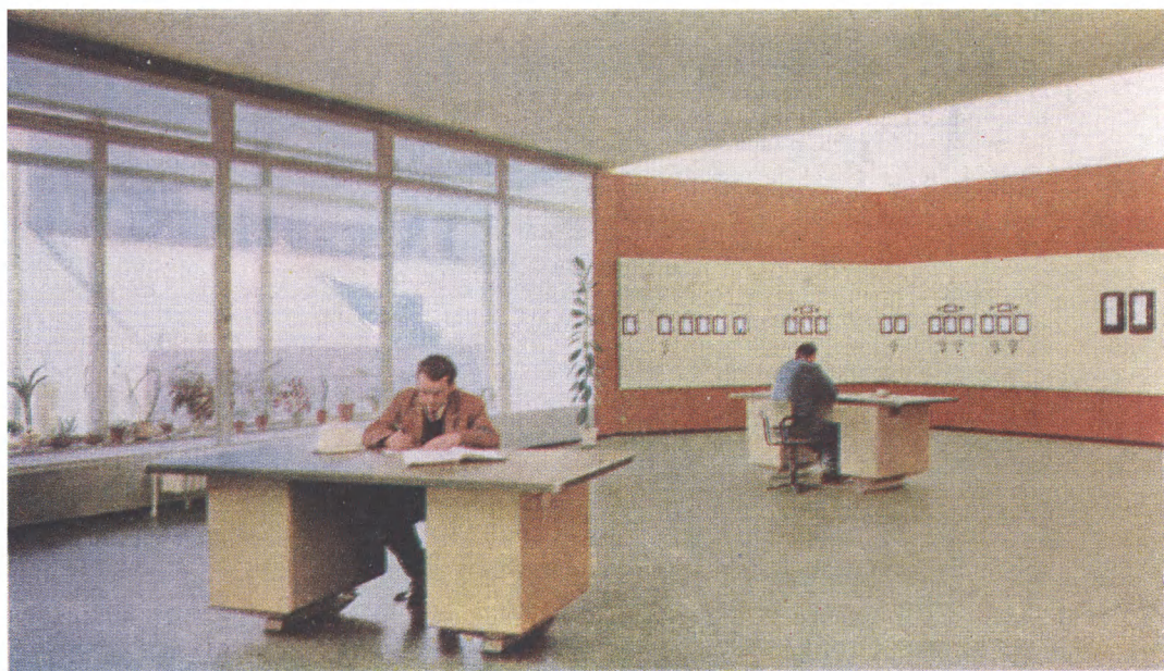
Фото 3. Мнемосхема технологического оборудования завода (фирма АЕС). Удачно выбран фон мнемосхемы, на котором четко выделяются все цвета технологических линий и условных обозначений агрегатов. Однако и цветовой контраст (изображение — фон) в некоторых местах следовало бы смягчить. Фото 4. Интерьер операторского пункта крупного технологического объекта выдержан в мягкой цветовой гамме. В качестве панели информации применена мнемосхема, схематически объединены и органы управления на пультах.
